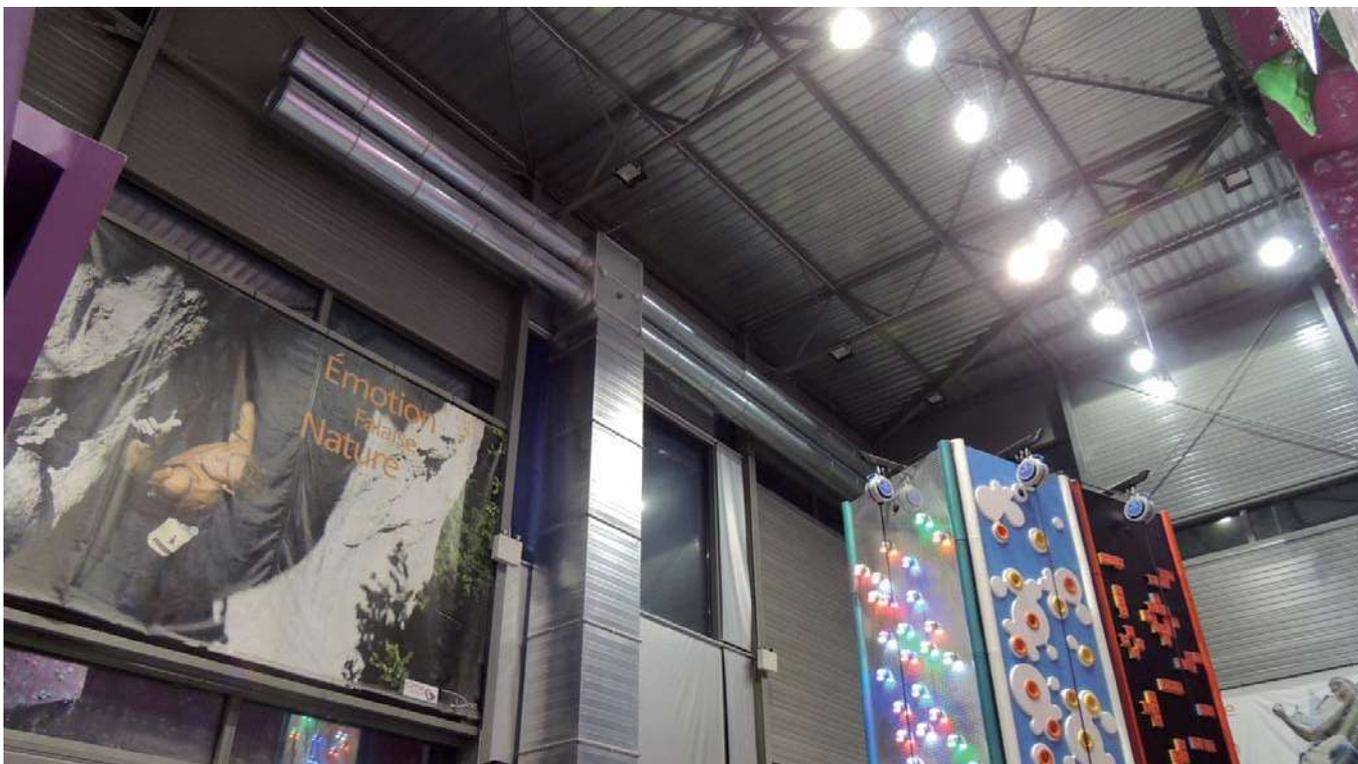
La toute nouvelle salle d'escalade de Dijon (Côte-d'Or) est chauffée et rafraîchie par vecteur air. Le brassage est assuré par un système à pulsion d'air, qui s'affranchit à la fois de la grande hauteur du local et des obstacles. Résultats : une température homogène et une consommation d'énergie réduite.
