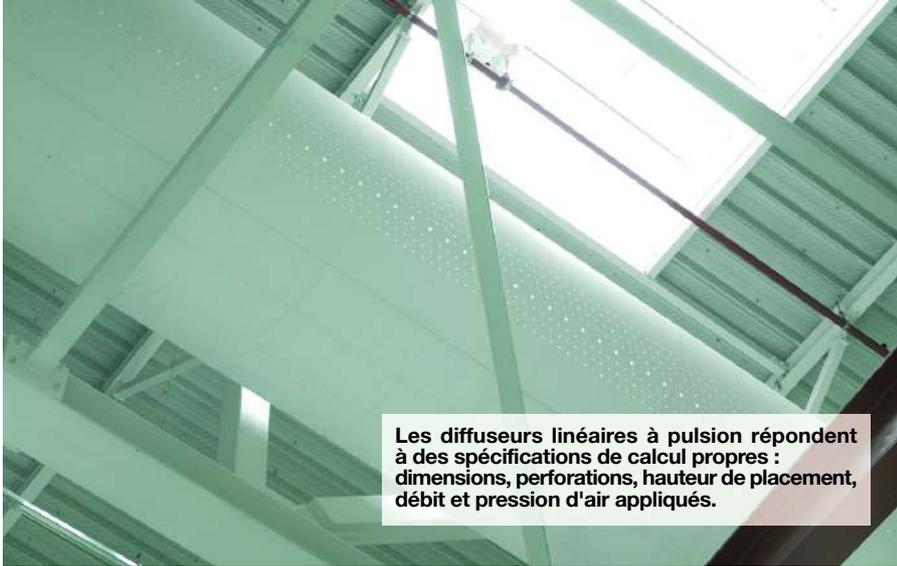
**Les diffuseurs linéaires à pulsion répondent à des spécifications de calcul propres : dimensions, perforations, hauteur de placement, débit et pression d'air appliqués.**
