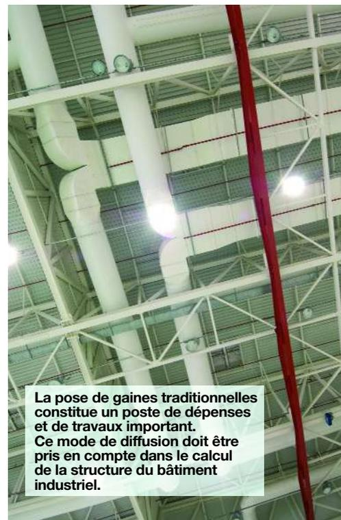
La pose de gaines traditionnelles constitue un poste de dépenses et de travaux important. Ce mode de diffusion doit être pris en compte dans le calcul de la structure du bâtiment industriel.
