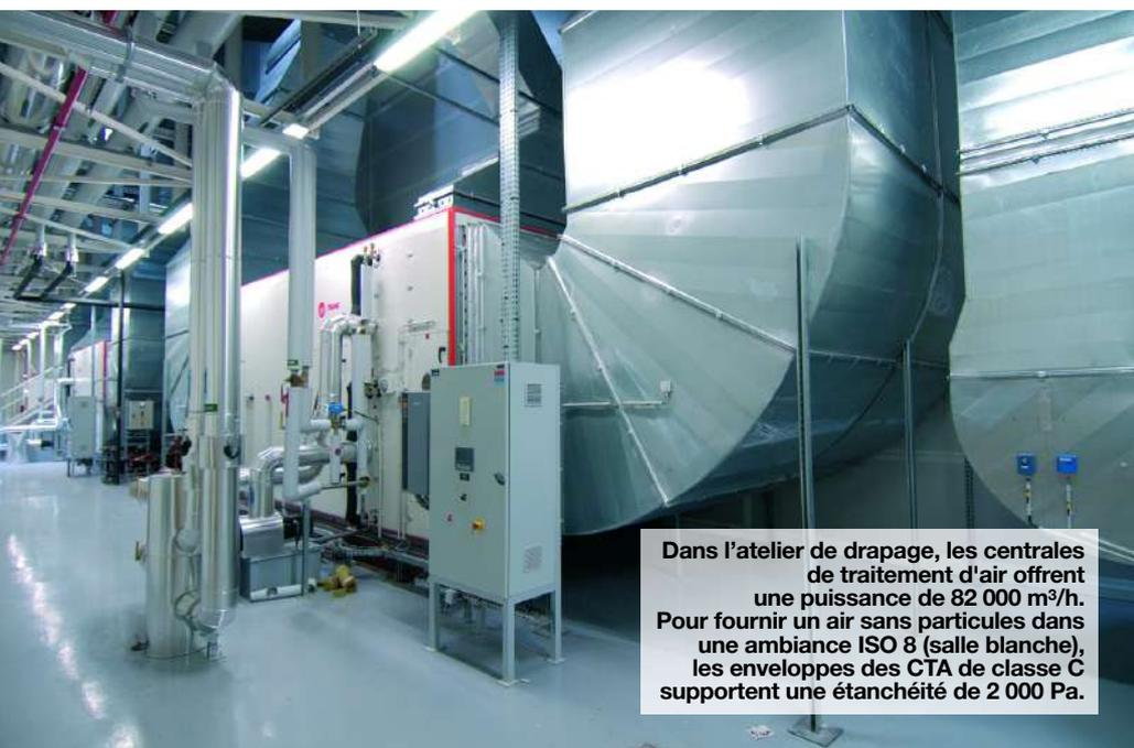
Dans l'atelier de drapage, les centrales de traitement d'air offrent une puissance de 82 000 m<sup>3</sup>/h. Pour fournir un air sans particules dans une ambiance ISO 8 (salle blanche), les enveloppes des CTA de classe C supportent une étanchéité de 2 000 Pa.
